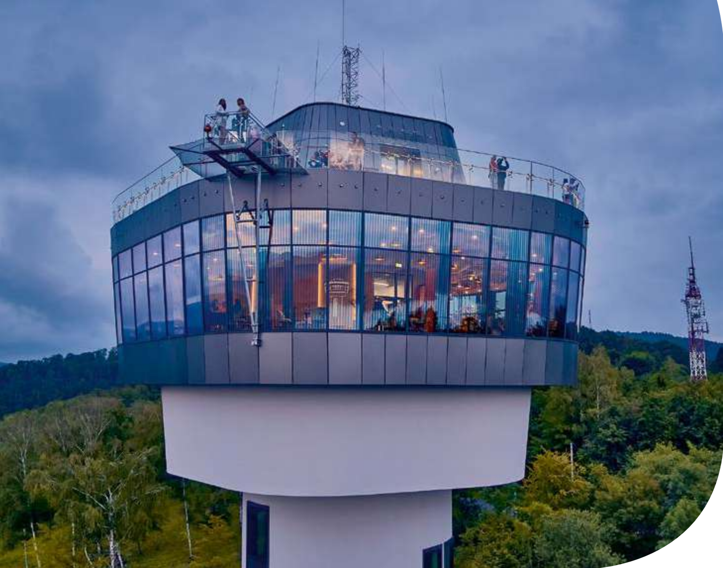
Solina utsiktstorn och gondolstation, Solina, Polen. Pilkington AviSafe™
