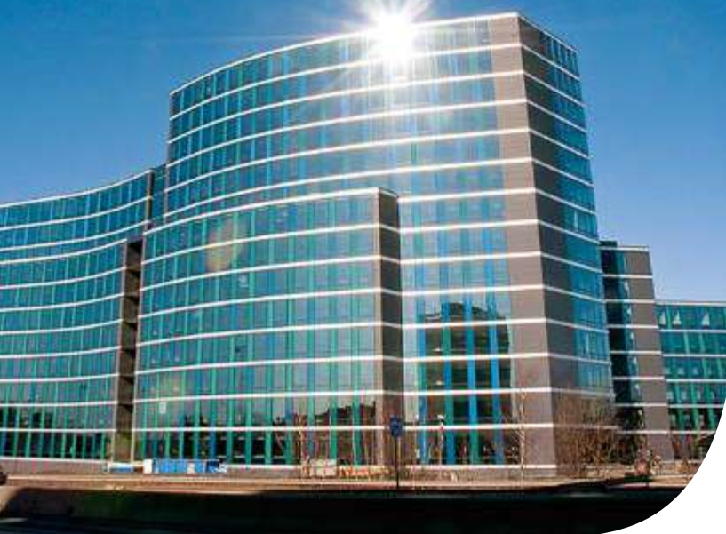
Foto: Trond Løvelsen / Byggeindustrien
