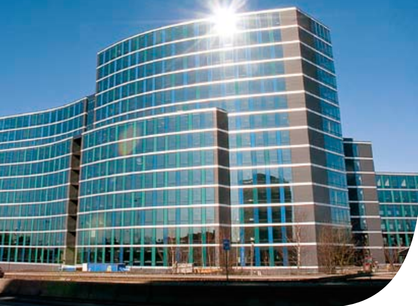
Foto: Trond Løvelsen / Byggeindustrien
