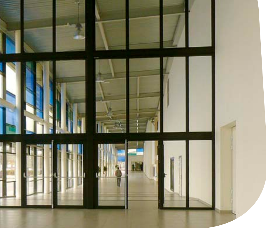
Halmstad Arena, Sverige. Pilkington Pyrodur ® Pilkington Pyrostop ® Ferdigstilt i 2009
