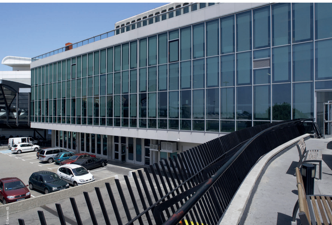
AA110, le mur-rideau Kawneer grande dimension, ici mis en œuvre à l'aéroport Lyon Saint-Exupéry (architecte Cabinet CRB Architecte). XB.
