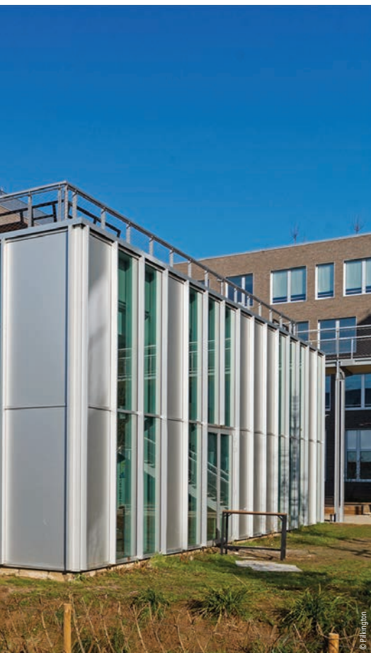
Le Suncool Q 60 de Pilkington fait partie des verres aux performances de transmission lumineuse élevées, comme ici sur le site de l'AgroParisTech à Palaiseau en banlieue parisienne
