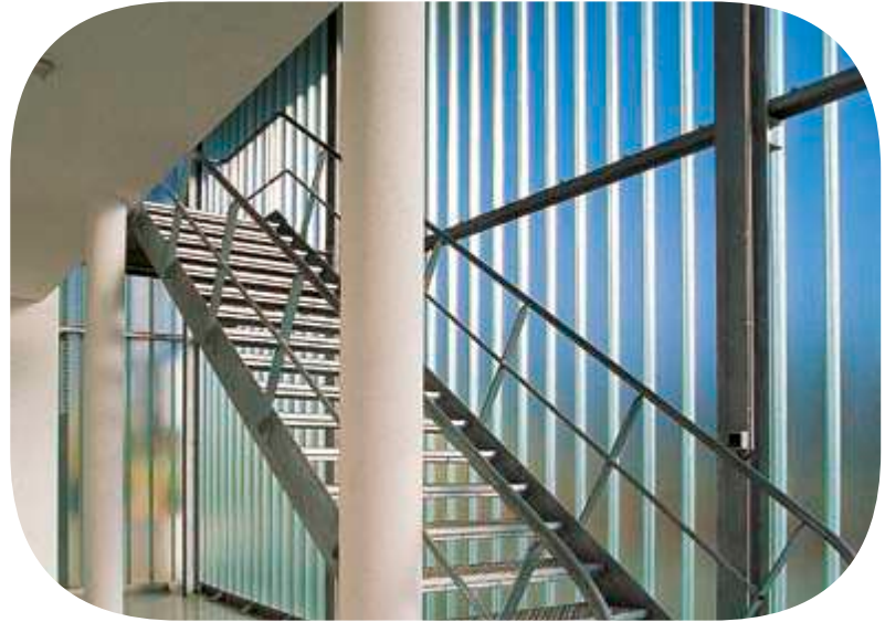
EDF sähköasema, Neuilly-sur-Marne, Ranska. Pilkington Profilit ™
