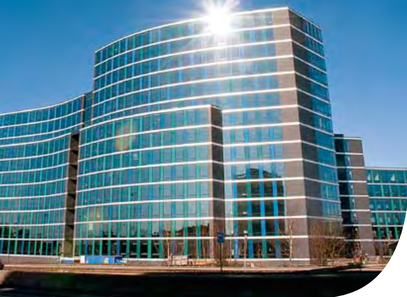
Foto: Trond Løvelsen / Byggeindustrien
