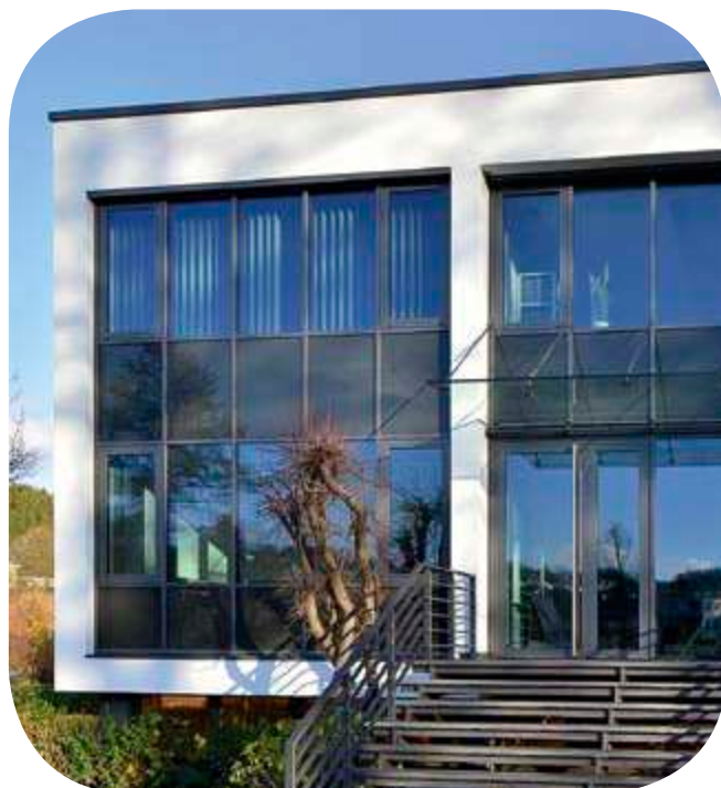
Kontorsbyggnad, Sundern, Tyskland. Pilkington Suncool™ Q 60
