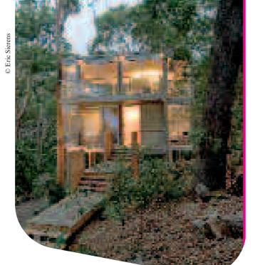
Решением стало использование оцинкованной стали для каркаса здания, а также самоочищающегося стекла Pilkington  $\mathbf{Activ}^{\scriptscriptstyle\mathsf{TM}}$  для остекления.
