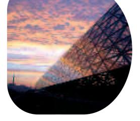
Sound Barrier состоит примерно из 150 сегментов. Основание треугольных стеклянных пластин — около 3 метров. Все 8320 пластин различаются по размеру, что значительно усложнило процесс логистики, как на стадии производства стекла, так и в ходе его монтажа.
