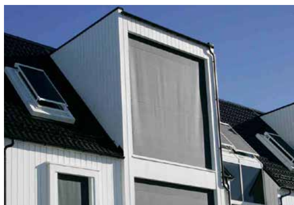
Eksempel på solskjerming som forhindrer kondensdannelse.
