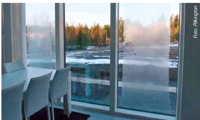
Utvendig kondens kan inntreffe på isolerruter med lav U-verdi. Antikondens-/duggbelegg bidrar til å redusere omfanget av dette.
