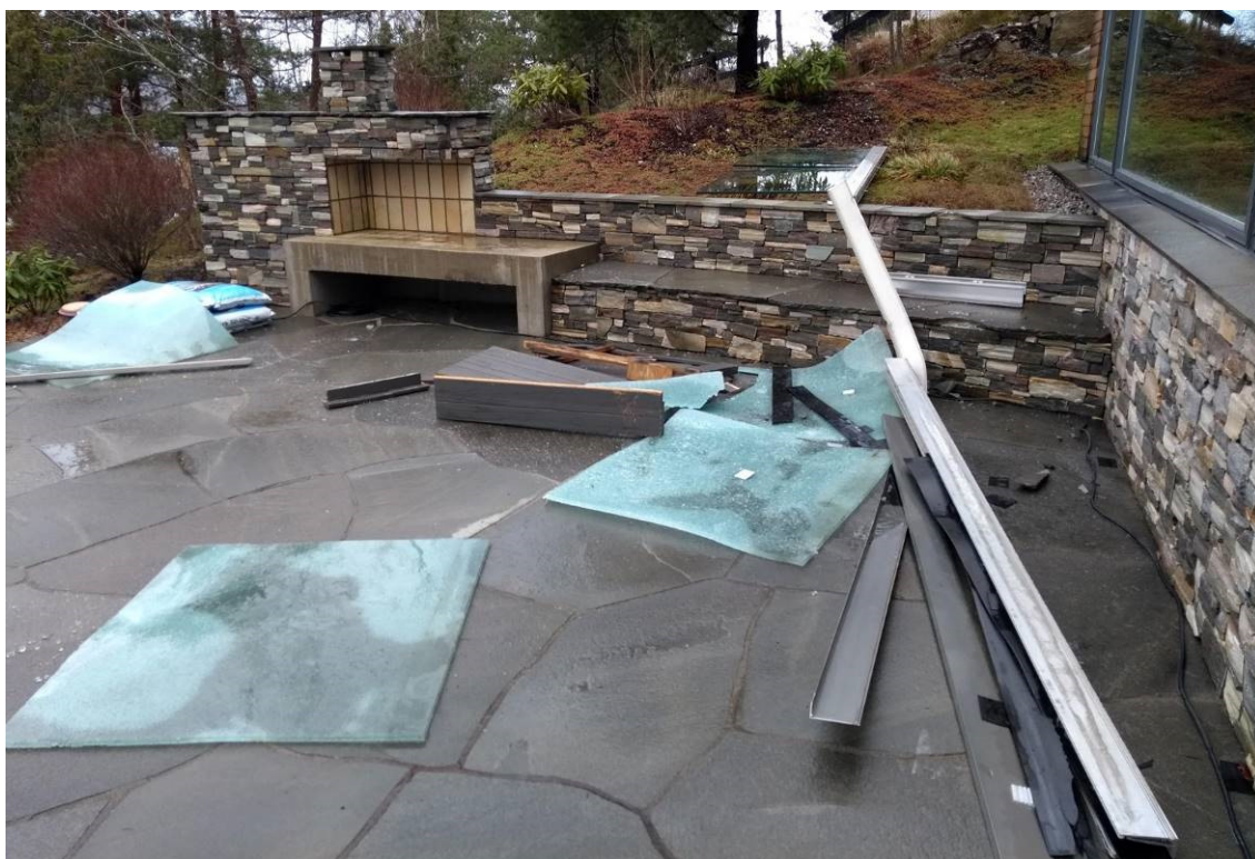
Figur 1 Eksempel fra en henvendelse som SINTEF har mottatt, hvor glassrekkverket på takterrassen har blåst ned. Årsaken var for dårlig innfesting i underlaget og store deler av rekkverket blåste ned. Heldigvis kom ingen til skade. Bildet er gjengitt med tillatelse av huseier. Foto: Anne Holmen
