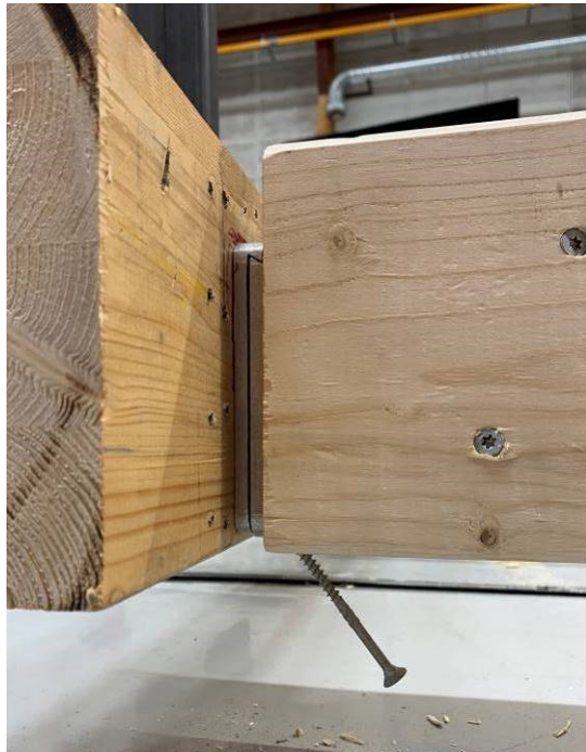
Figur 59 Låsning av beslag med stikkskrue fra undersiden
