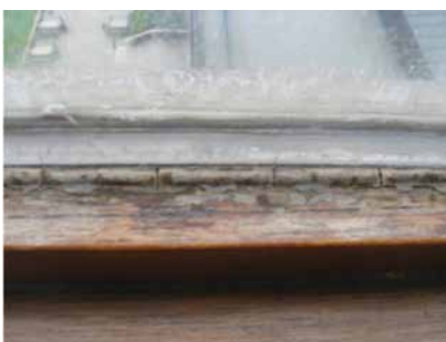
Bilde 1: Vindu med asbestholdig kitt.
