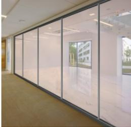
Innere Trennwand mit Pilkington **Pyrostop**<sup>®</sup> Line: Brandschutz der Feuerwiderstandsklasse EI 30 in flächenbündigem Design ohne Vertikalrahmung.
