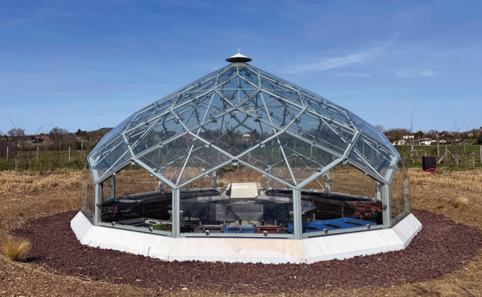
levées par le projet. Dans cette optique, et après avoir identifié les potentiels et limites propres aux coupôles triangulées et peaux minces de type géode, un autre genre de polyèdre a été retenu : le projet repose sur la géométrie d'un rhombizonoèdre polaire de révolution, plus connu sous le nom de "zome", c'est-à-dire un polyèdre doté d'une symétrie de révolution à double spirale autour d'un axe, et composé de faces en forme de losanges », poursuit Yann Rocher.
