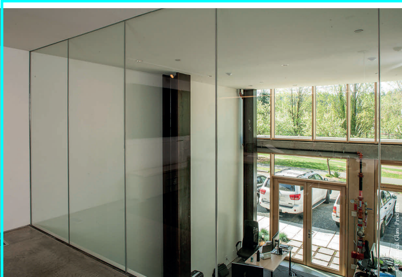
Cloison vitrée bord à bord Pyrostop Line (Pilkington) assurant une protection contre les incendies et une fonction garde corps.
