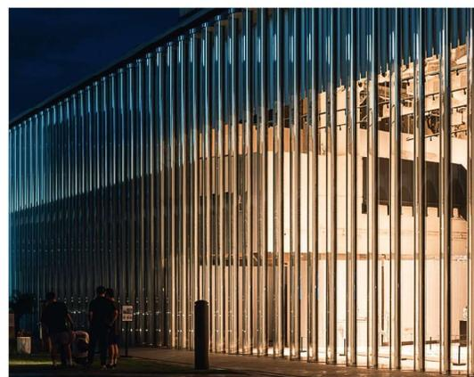
dulée irrégulière et comprend 343 panneaux de verre incurvés mesurant 2,7 sur 3,5 mètres et pesant entre 600 et 1 250 kg. Les panneaux de verre reposent sur seulement quatre points d'appui en acier inoxydable, donnant à la façade une impression d'équilibre et de légèreté.
