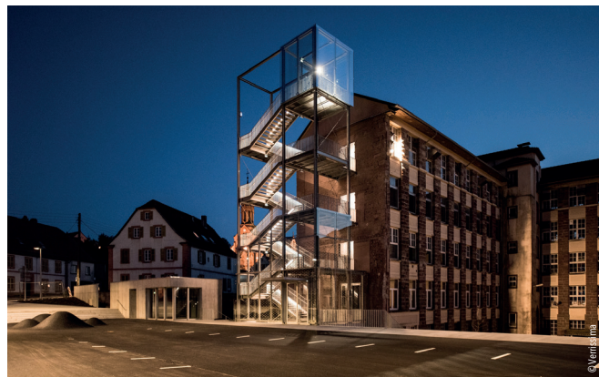
Belvédère dans le centre de Goetzenbruck avec 300 m² de parois vitrées signées Verrissima
