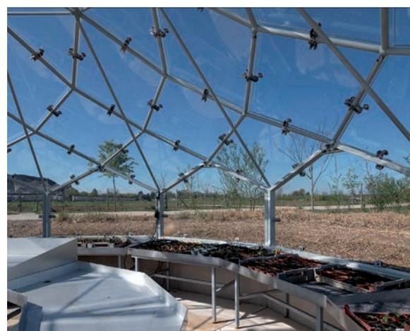
72 panneaux de verre, découpés par jet d'eau selon des gabarits en losange, ainsi que leurs perçages pour les pièces de fixation, composent la peau cristalline de la coupole. ©K. Khalfi
