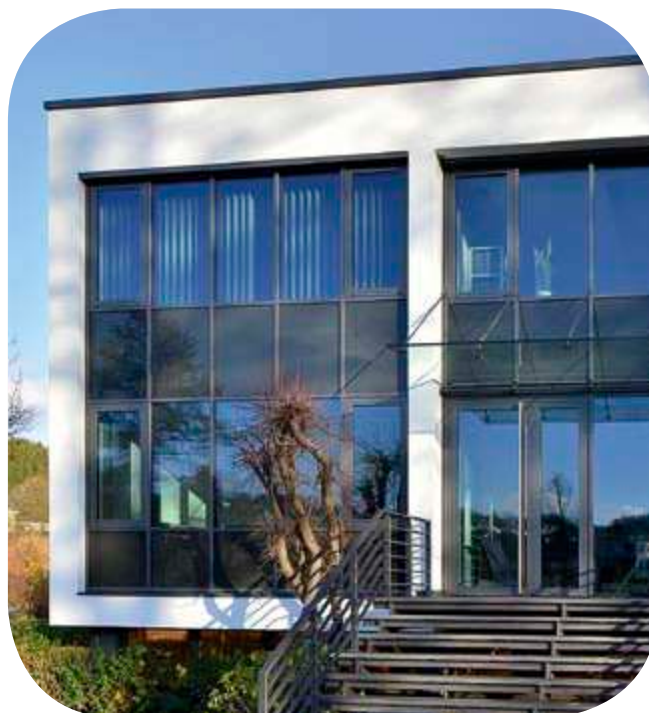
Kontorbygning, Sundern, Tyskland. Pilkington Suncool™ Q 60
