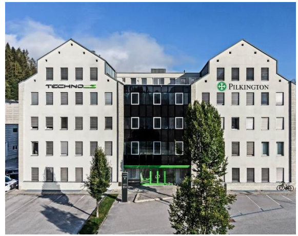
Weltneuheit – ganzflächige BIPV Fassade bei Pilkington Austria
