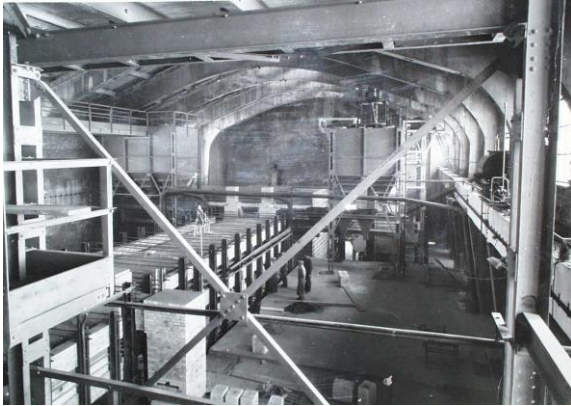
Mitterberger Glashütte: Schmelzofen vor der Fourcault-Ziehmaschine
