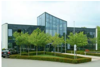
Hauptverwaltung Firma Pennekamp GmbH & Co. OHG, Ennepetal Pilkington Activ Suncool™ 50/25
