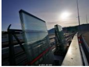
San-Giorgio-Brücke in Genua, Italien Pilkington Optiwhite™
